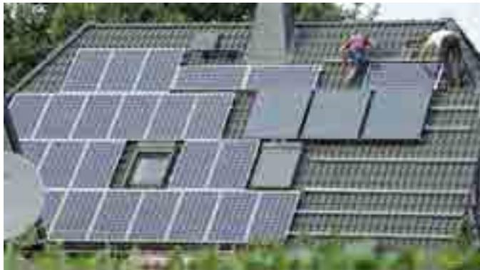
Abb. 2.16: kombinierte Photovoltaik- und Solarthermieanlage
